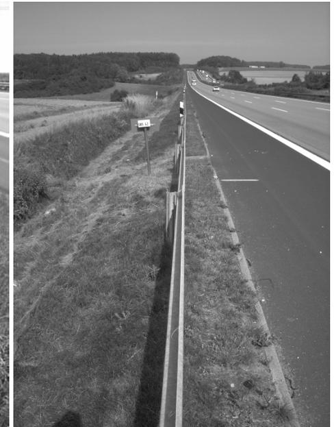
Abb. 2: Probefläche auf der Westseite der A 7. Die Bankette ist durch eine Bordsteinkante von der Fahrbahndecke abgesetzt und mit einer Leitplanke versehen. Das salzhaltige Wasser ist am direkten Eindringen gehindert.
